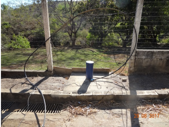
Foto 1 – Poço da área de captação e EEAB Piancó II em obras.
