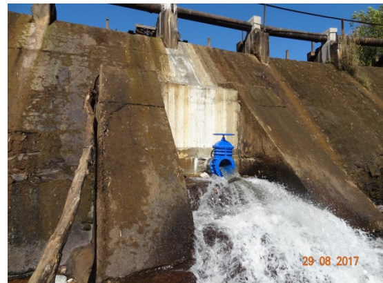
Foto 4 – Barra vedar da comporta, barragem Piancó II.
