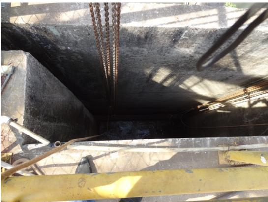
**Foto 1** – Captação Meia Ponte: Abertura lateral para passagem de água
