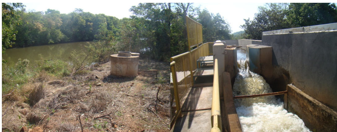
Foto 1 - Manancial Foto 2 - Entrada tratamento - ETA
