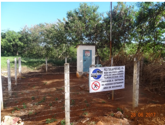
Foto 7 - Poço P14 com acesso fácil.
