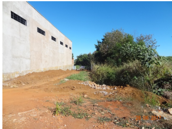
Foto 6 – Poço P14 com acesso fácil.
