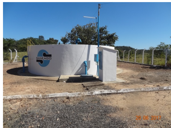
Foto 2 – RAP com pintura recuperada.
