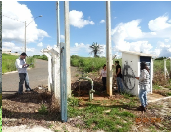
Foto 5 - Poço Português - cerca danificada
