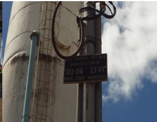
Foto 18 – Res. São Marcos com pintura desgastada
