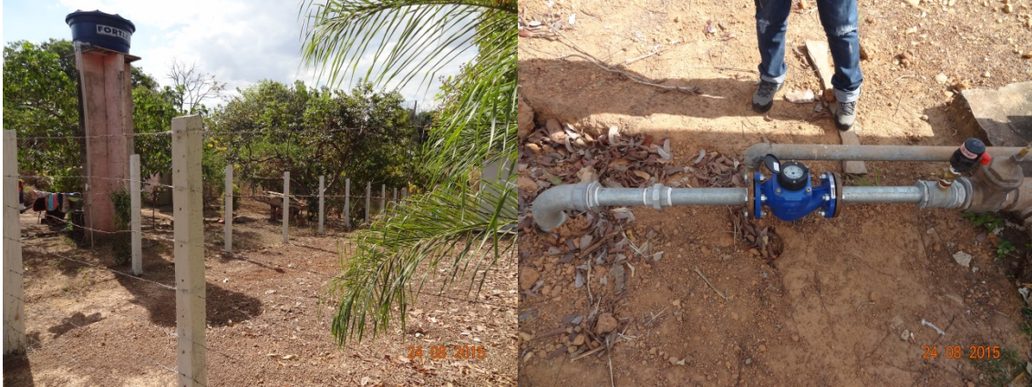
Foto 1 – Cerca recuperada Foto 2 – Macromedidor instalado
