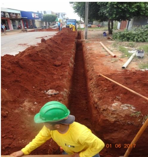
**Foto 7** - Obras de esgotamento sanitário em execução
