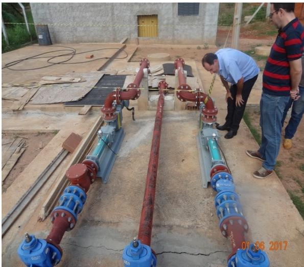
**Foto 5** - Nova Estação Elevatória de Esgoto (EEE)
