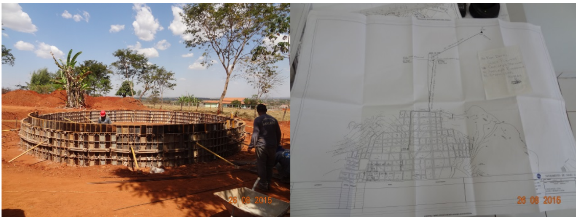
Foto 1 – Ampliação do sistema Foto 2 – Projeto de ampliação
