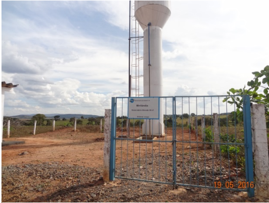
Foto 1 – Cerca recuperada na área do REL.
