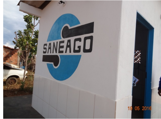
Foto 2 – Abrigo de cloração com revestimento recuperado.
