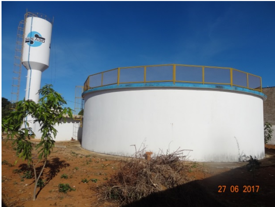
Foto 1 – RAP do escritório com pintura recuperada.
