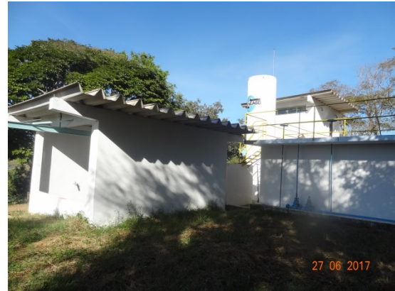
Foto 2 – ETA com pintura e revestimento recuperados.
