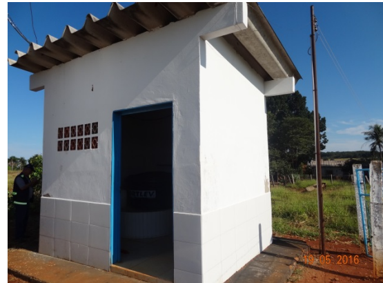
Foto 2 – Abrigo de cloração recuperada.
