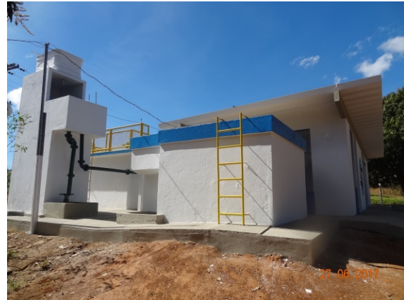
Foto 4 – Tanque de contato com pintura recuperada.
