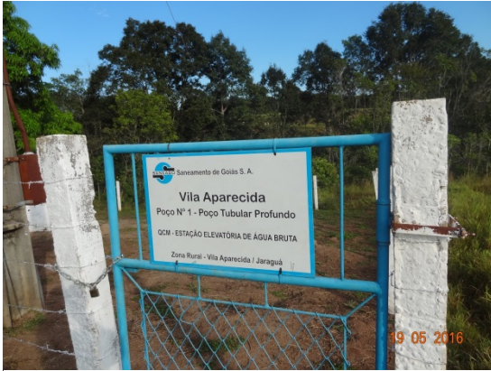
Foto 1 – Poço com identificação.
