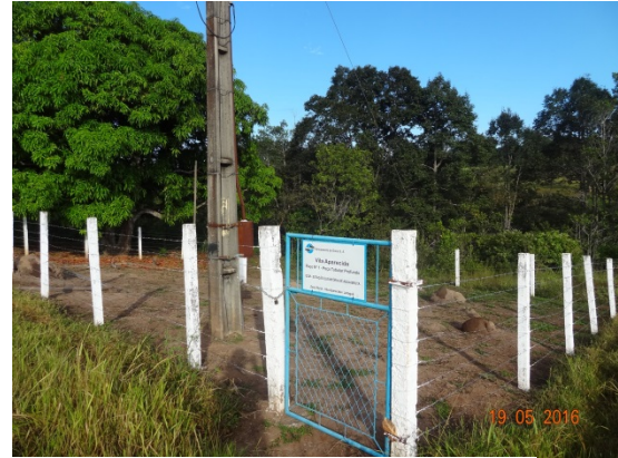
Foto 2 – Poço com cerca de proteção.
