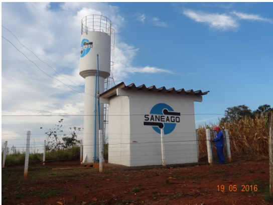
Foto 3 – Abrigo de cloração recuperado.
