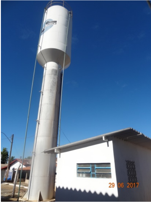
Foto 1 – Reservatório com pintura recuperada e ausência de corrosão.
