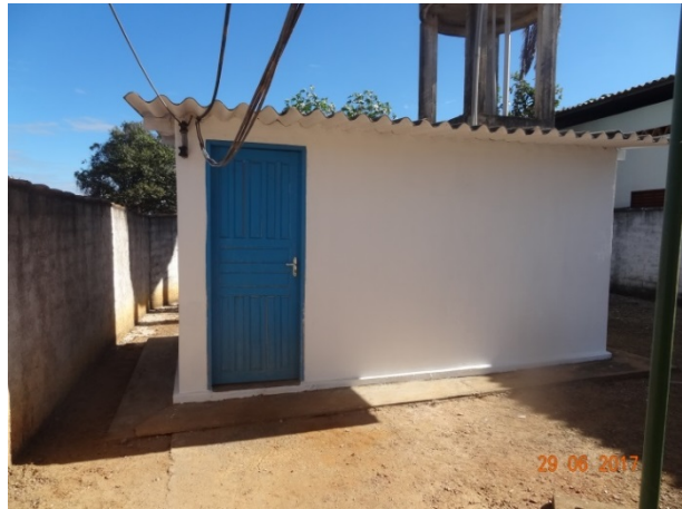
Foto 2 – Sala do clorador com porta, pintura e revestimento recuperados
