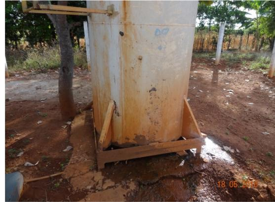
**Foto 4** – REL com pintura desgastada e vazamentos.
