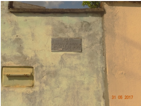
Foto 11 - Indícios de rede executada Contrato nº. 095/2010 - Jardim Guanabara
