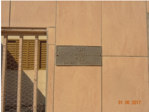
Foto 1 -Obras de modulação / recuperação em execução - Bairro Colegial
