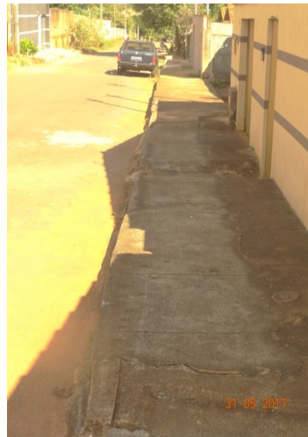
Foto 13 - Indícios de rede executada Contrato nº. 095/2010 - Jardim Guanabara
