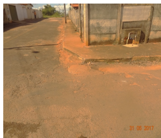
Foto 8 - Indícios da rede executada Contrato nº. 095/2010 - Santa Cecília
