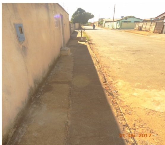
Foto 7 - Indícios da rede executada Contrato nº. 095/2010 - Santa Cecília
