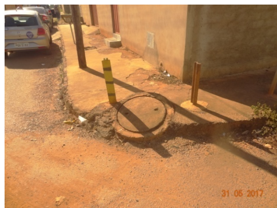
Foto 6 - Indícios da rede executada Contrato nº. 095/2010 - Santa Cecília
