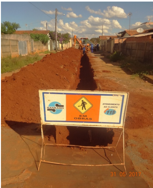
Foto 3 -Obras de modulação / recuperação em execução - Bairro Colegial
