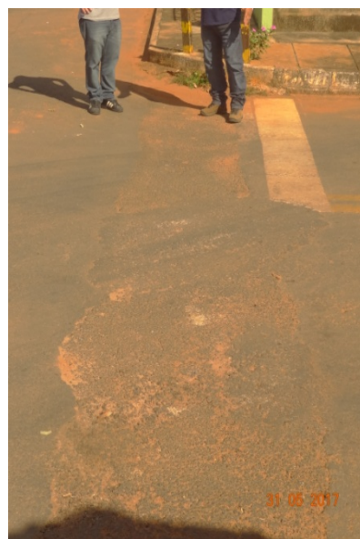
Foto 14 - Índícios de rede executada Contrato nº. 095/2010 - Jardim Guanabara
