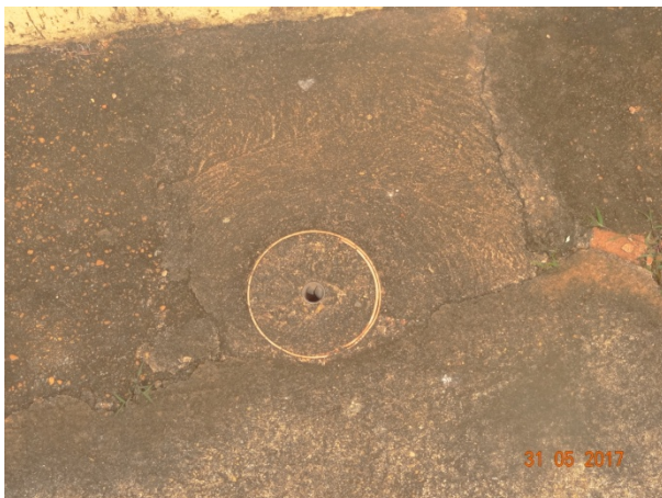
Foto 13 - Índícios de rede executada Contrato nº. 095/2010 - Jardim Guanabara
