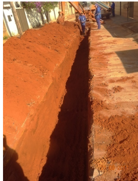
Foto 4 -Obras de modulação / recuperação em execução - Bairro Colegial
