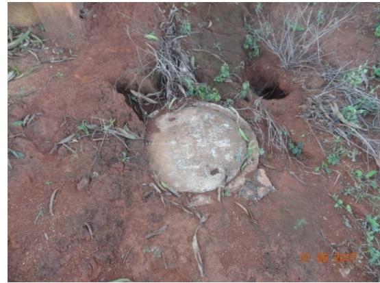
Foto 10 -Indícios de rede executada Contrato nº. 095/2010 - Jardim Sonho Verde
