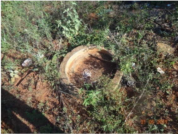
Foto 9 -Indícios de rede executada Contrato nº. 095/2010 - Jardim Sonho Verde
