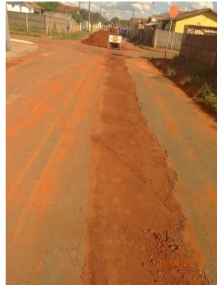
Foto 2 -Obras de modulação / recuperação em execução - Bairro Colegial
