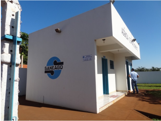
Foto 1 – Escritório com pintura recuperada
