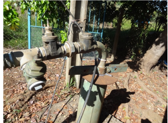
Foto 2 - Poço com válvula recuperada
