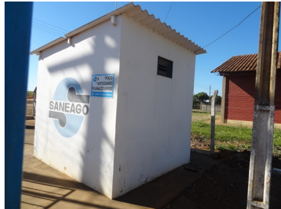
Foto 2 - Abrigo com revestimento recuperado
