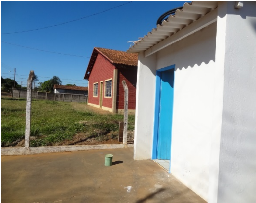
Foto 1 – Abrigo com pintura e porta recuperada
