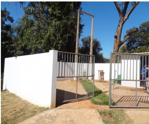
Foto 1 – Poço sem identificação
