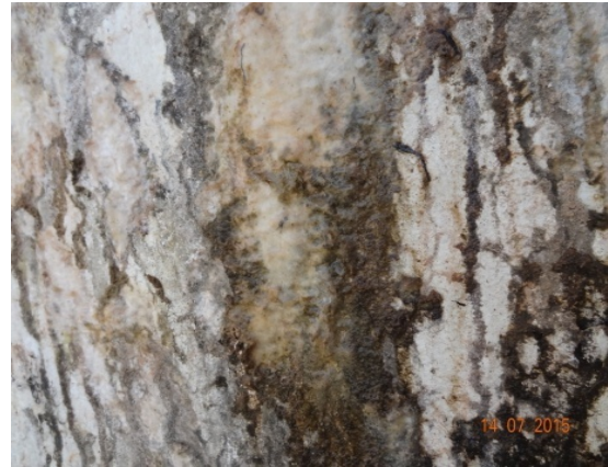
Foto 8 – Presença de infiltração e mofo
