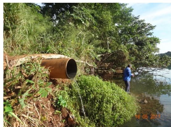
Foto 4 – Ponto de lançamento do by-pass da EEE IV
