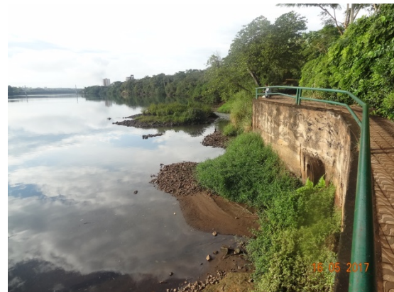
Foto 2 – Ponto lançamento do by-pass da EEE III
