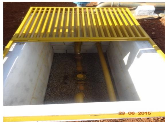
**Foto 2:** Instalação de macromedidor
