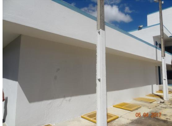
**Foto 2** - ETA com correção de eflorescências e perda de revestimento na área externa.
