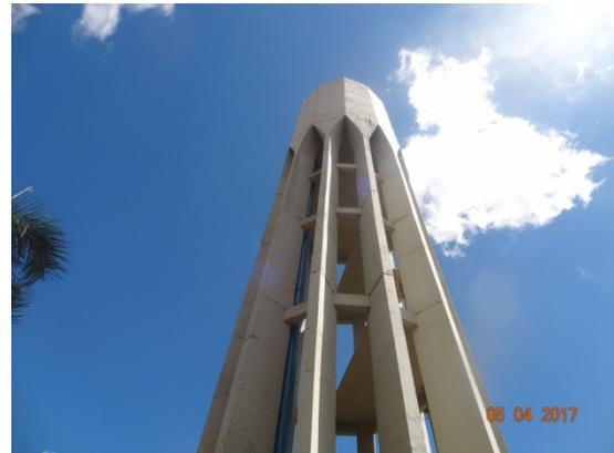
**Foto 6** - Reservatório Setor Tolentino II com pintura recuperada e ausência de eflorescências.
