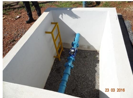
**Foto 6** – Dispositivo de macromedição instalado
