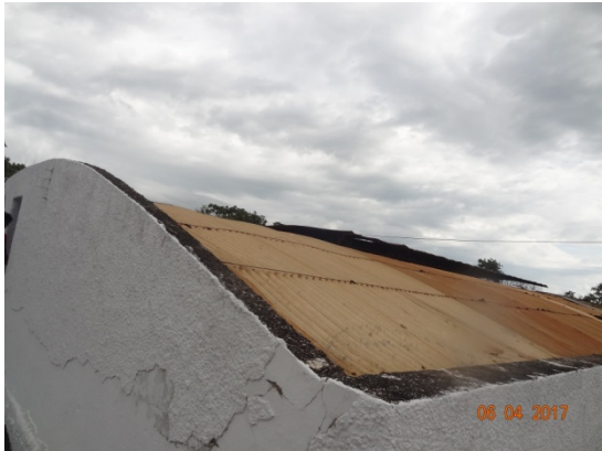
Foto 5 - Reservatório B - reparada pintura e revestimento.
