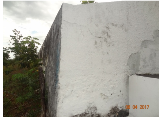
Foto 6 - Reservatório B - reparado local em que havia ferragem de aço exposta e com ferrugem.
