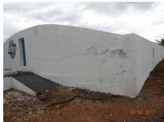
Foto 4 - Reservatório B - reparada pintura e revestimento.
