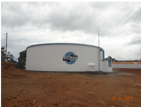
Foto 3 - Reservatório A - reparada pintura e revestimento.
