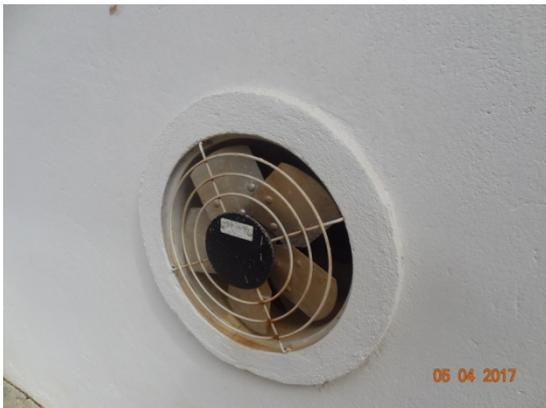
**Foto 3**–ETA - Exaustor da sala do clorador reparado.
