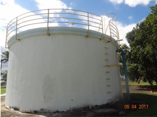
**Foto 1** – Reservatório R1 com guarda-corpo na escada.
