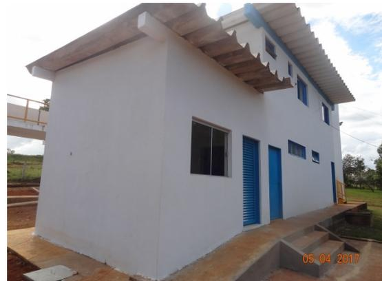
**Foto 4** – ETA com pintura recuperada, ausência de infiltrações e eflorescências.
