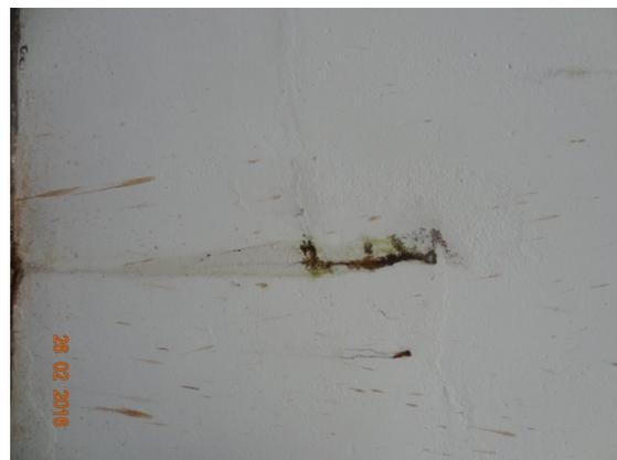
**Foto 2** – Ponto de infiltração na ETA (floculador e decantador).
