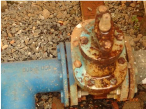
**Foto 7** – Vazamento no reservatório Pérola do Sul
