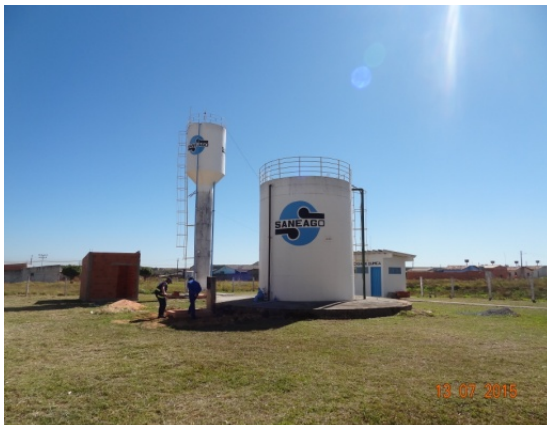
Foto 1 – Res. com macro medidor instalado
