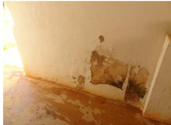
**Foto 2** – Perda de revestimento na estrutura da ETA.
