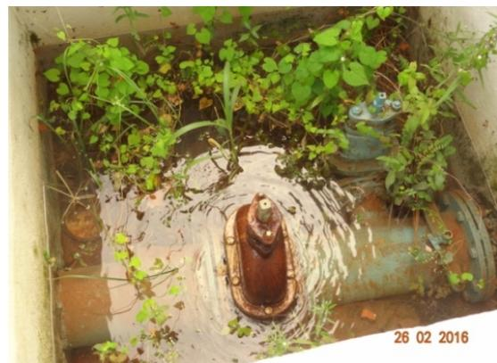
**Foto 4** - Vazamento no registro de saída do Reservatório Elevado.
