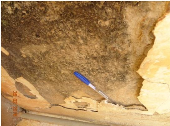
**Foto 1** – Perda de revestimento no poço de sucção (captção).
