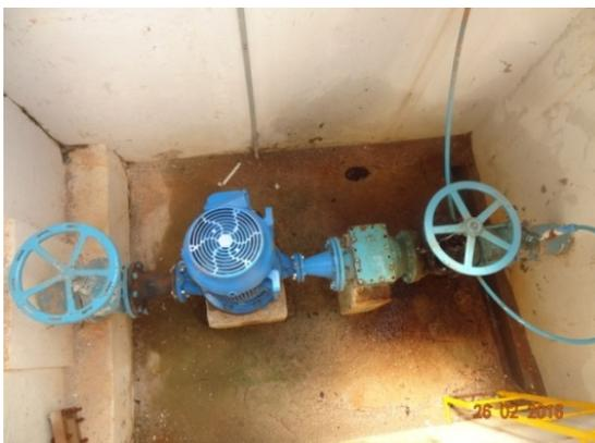
**Foto 3** – Vazamento na gaxeta do registro (ETA).
