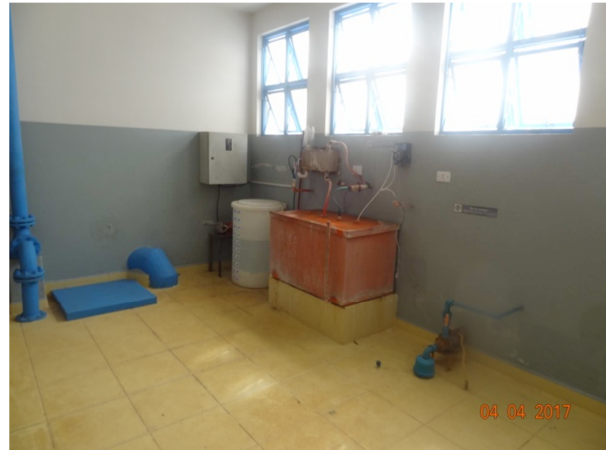
Foto 6 - ETA - Pintura reparada - Casa de Química
