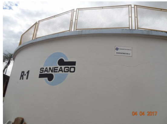
Foto 10 - Instalação de guarda-corpo - reservatório R1
