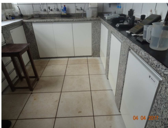
Foto 3 - ETA - armários reparados no Laboratório
