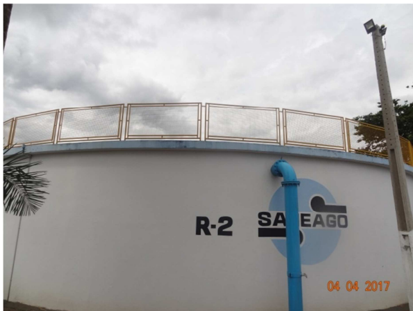
Foto 11 - Instalação de guarda-corpo - reservatório R2
