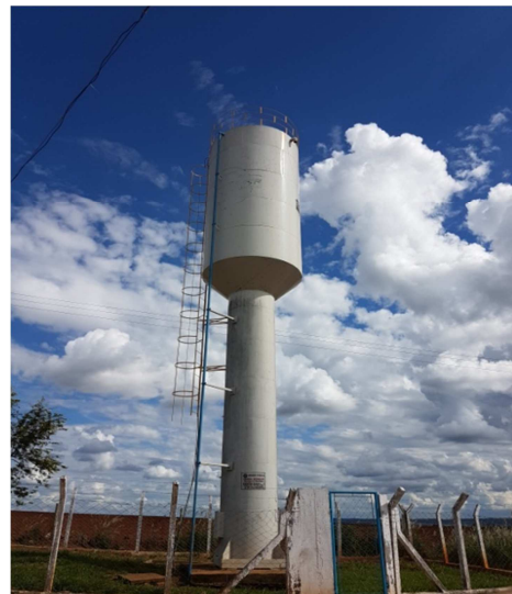
Foto 12 - Instalação de cerca de proteção e portão - Reservatório Setor Sol Nascente
