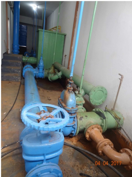
Foto 5 - ETA - Pintura reparada - área de filtração
