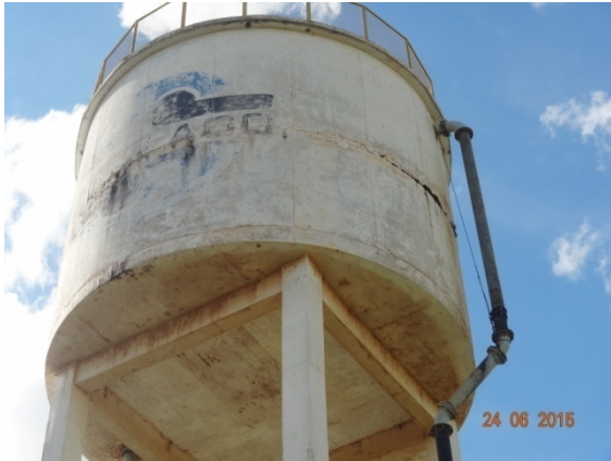
Foto 5 – CR Munir Calixto – Recuperação de eflorescências com impermeabilização interna
