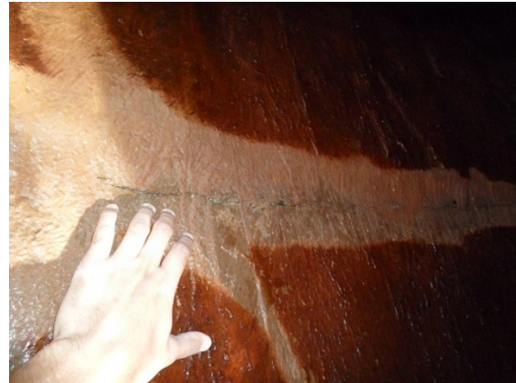
Foto 5 – CR Munir Calixto – Recuperação de eflorescências com impermeabilização interna
