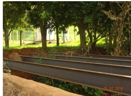
Foto 2 – Ponte de acesso ao poço P9 em execução.
