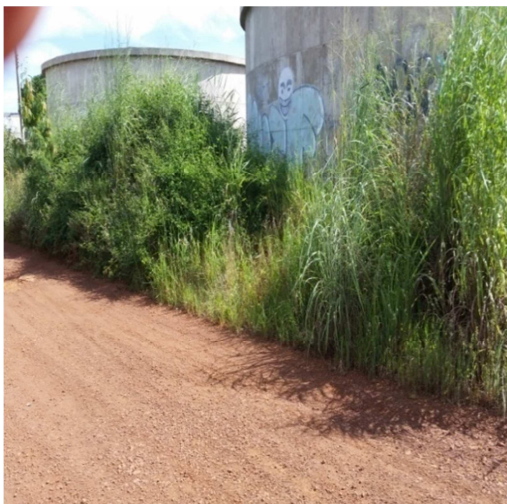
Foto 21 - Novos RAP do Sistema Santa Fé (Área 3)
