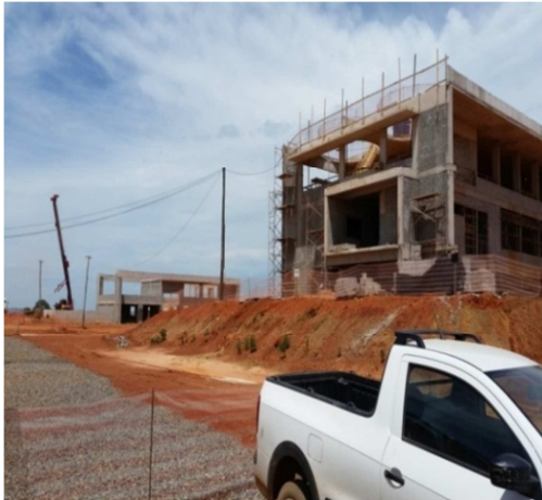
Foto 15 - ETA - Prédio Administração e início área Casa de Química - 31/03 e 1º/04
