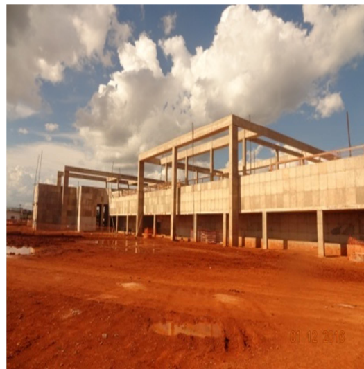
Foto 18 - ETA - Obras área Tanques de Tratamento - 1º e 2/12
