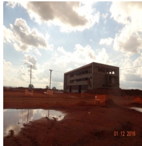
Foto 14 - ETA - Prédio Administração - 1º e 2/12
