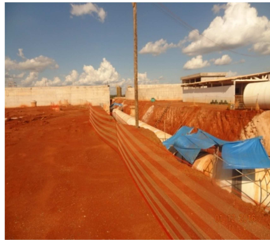
Foto 20 - Interligações área de Tanques - 1º e 2/12
