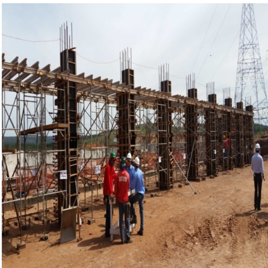
Foto 1 - Início amarração estruturas na EEAB Corumbá - 31/03 e 1º/04
