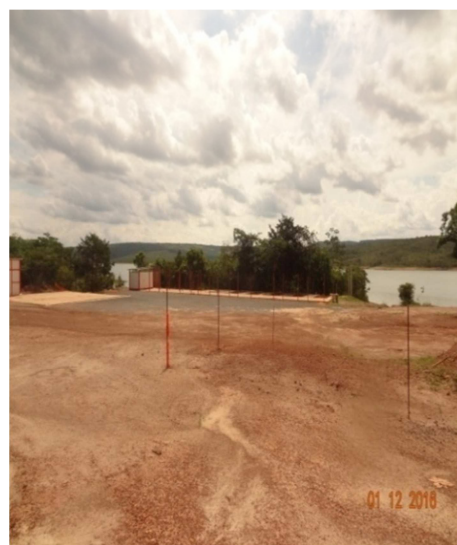
Foto 2 - Removidas salas da Administração obras na EEAB Corumbá-1º e 02/12
