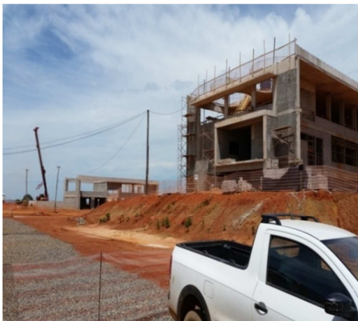
Foto 13 -ETA - Prédio Administração e início área Casa de Química - 31/03 e 1º/04
