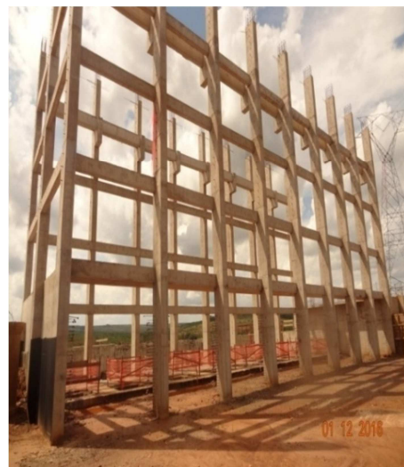
Foto 6 - Estruturas já construídas na EEAB Corumbá- 1º e 02/12
