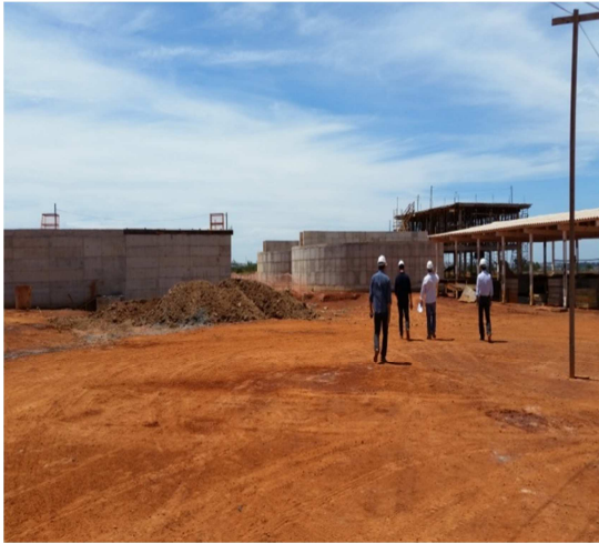
Foto 19 - Obras área Tanques de Tratamento - 31/03 e 1º/04
