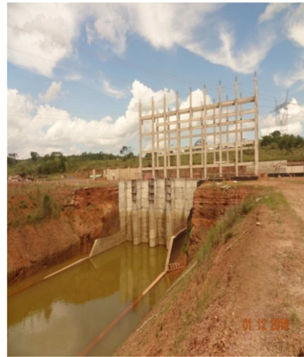
Foto 8 - Entrada água e estrutura na EEAB Corumbá -1º e 02/12
