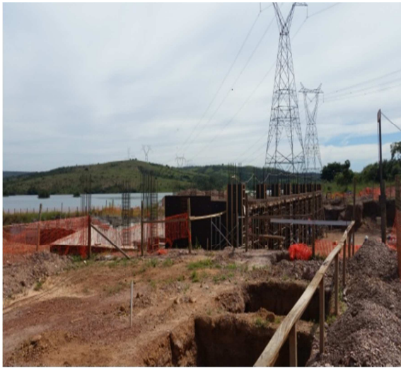
Foto 3 - Escavações na EEAB Corumbá- 31/03 e 1º/04
