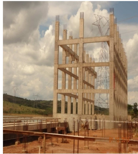
Foto 4 - Estruturas já construídas na EEAB Corumbá-1º e 02/12
