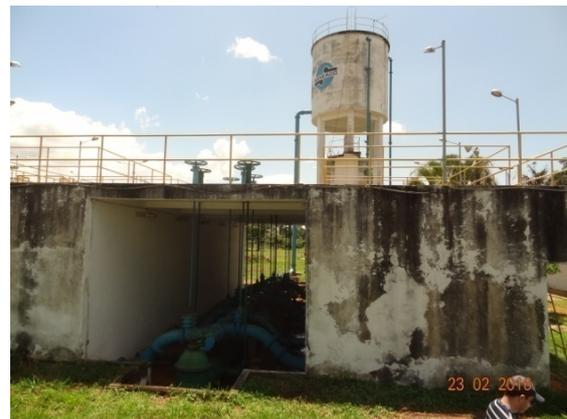
**Foto 2** - Pintura desgastada e perda de revestimento na ETA.
