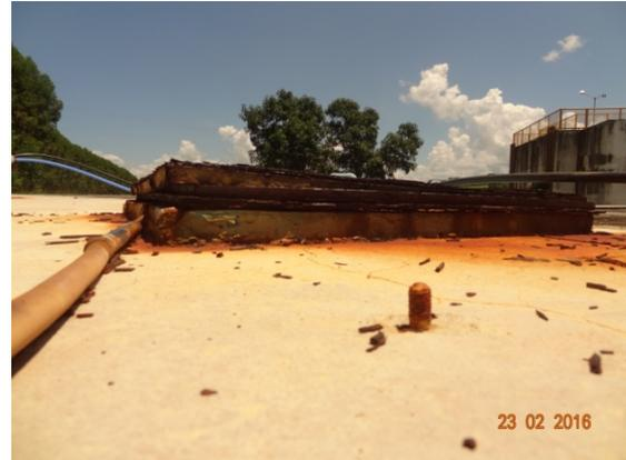
**Foto 6** - Tampa de inspeção corroída no reservatório da ETA.
