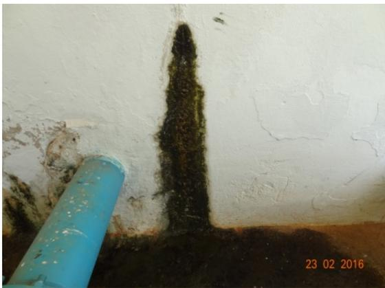
**Foto 1** - Infiltração e bolor na galeria dos filtros (ETA).
