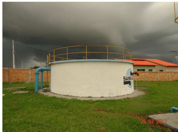
Foto 2 – RAP R1 com infiltrações corrigidas
