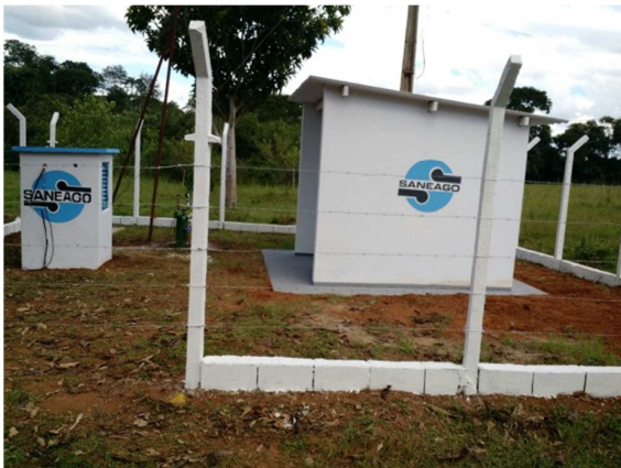
Foto 3 – Casa de cloração recuperada
