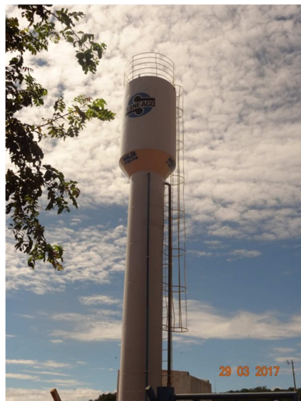
Foto 4 – REL substituído por um novo
