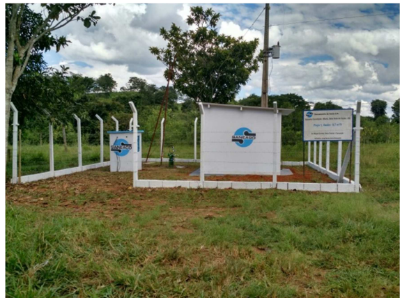
Foto 2 – Área do SAA recuperada e urbanizada
