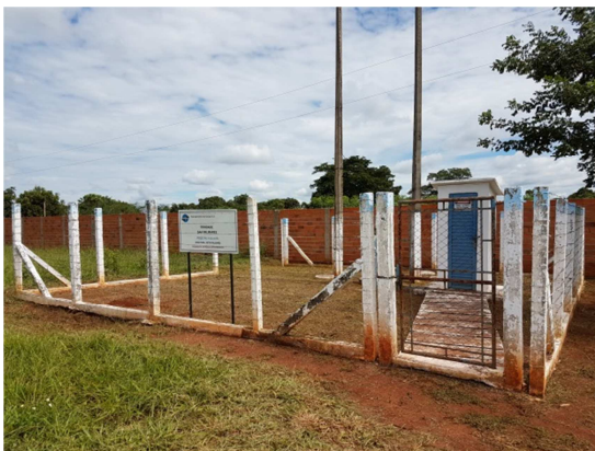
Foto 3 – Poço Palmares P04 com cerca de proteção recuperada.
