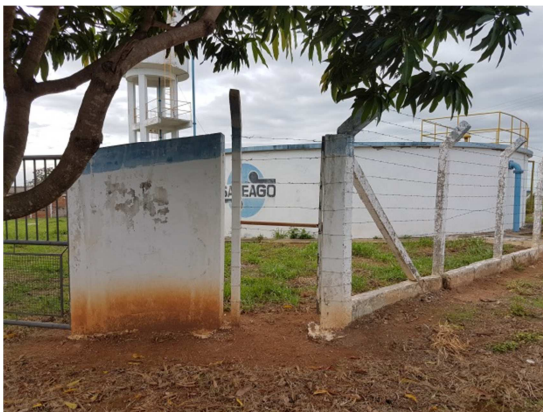
Foto 1 – Reservatório Sol Dourado com portão e cerca de proteção.
