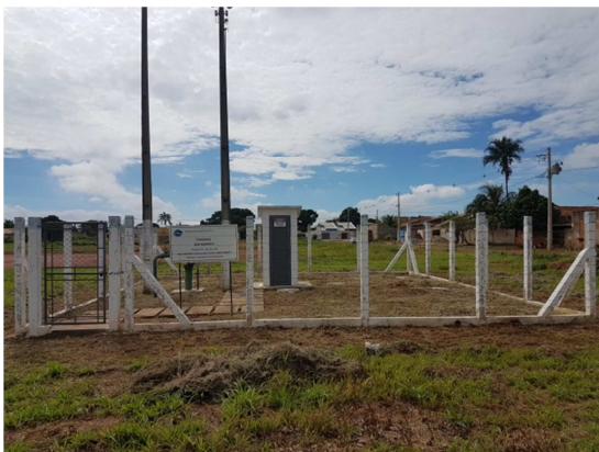
Foto 7 – Área do Poço P05 (SAA Marista) em boas condições de limpeza.
