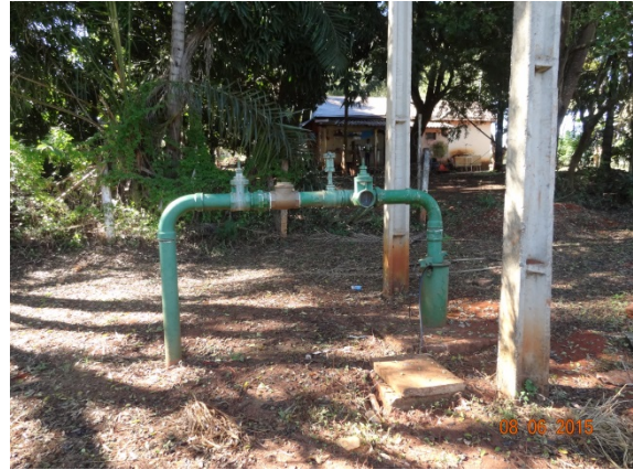
Foto 2 - Poço 10 sem identificação
