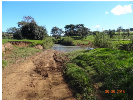
Foto 4 - Passagem de acesso ao poço 09
