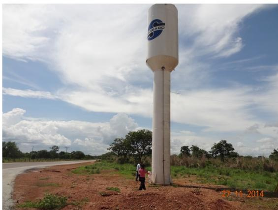
**Foto 3** – Ausência de guarda corpo e cerca de proteção.
