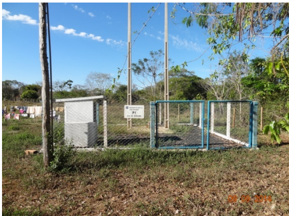
Foto 1 – Inexistência de cadeado no portão
