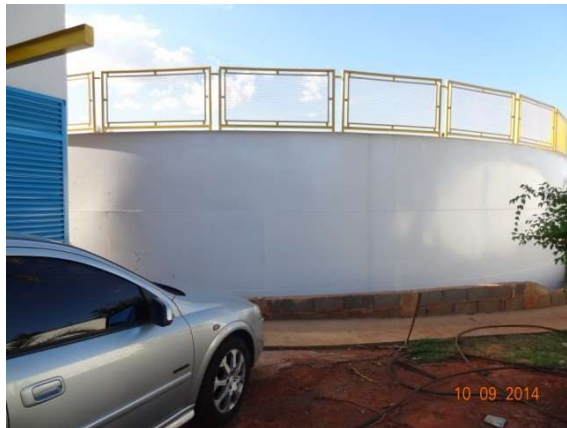
Foto 1 – Novo reservatório de 10.000 m 3
