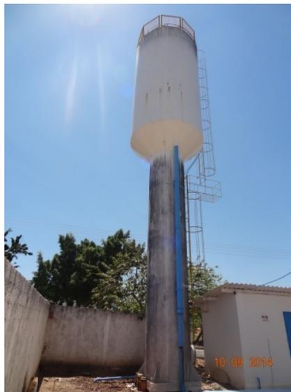
**Foto 1** – Pintura recuperada e guarda corpo instalado.
