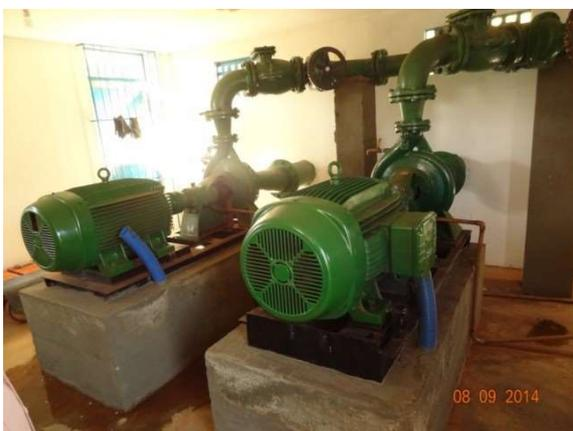
**Foto 1** – Bombas substituídas (31m<sup>3</sup>/h)
