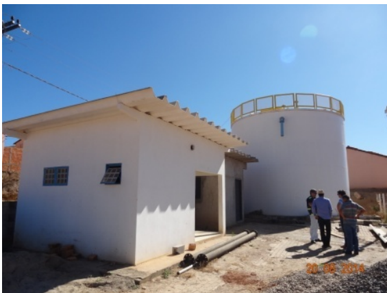
Foto 1 – Res. apoiado 300m 3 - St. Sta. Luzia
