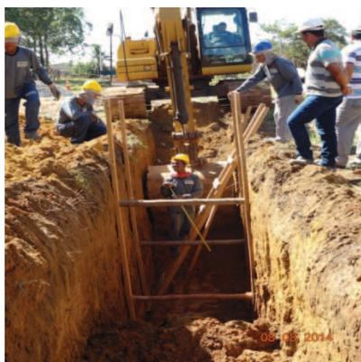
**Foto 9 – Extensão de rede água**
