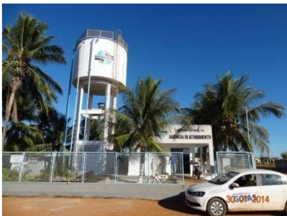
Foto 1 – Reservatório em uso no distrito
