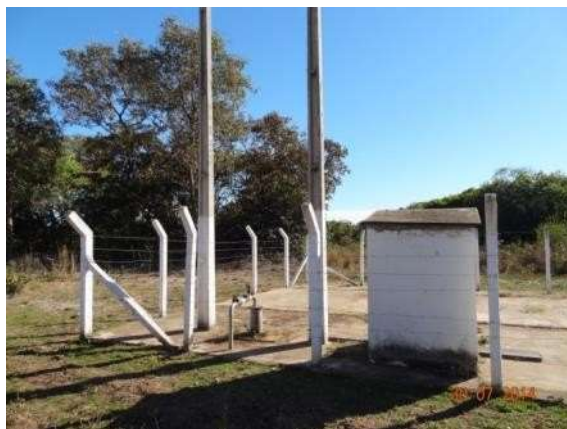
Foto 5 – Poço 12 – Vazão 12 m 3 /h
