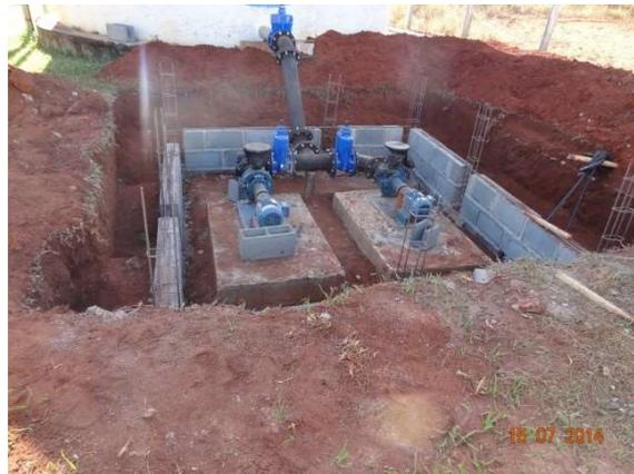
**Foto 2** – Sistema de bombeamento novo
