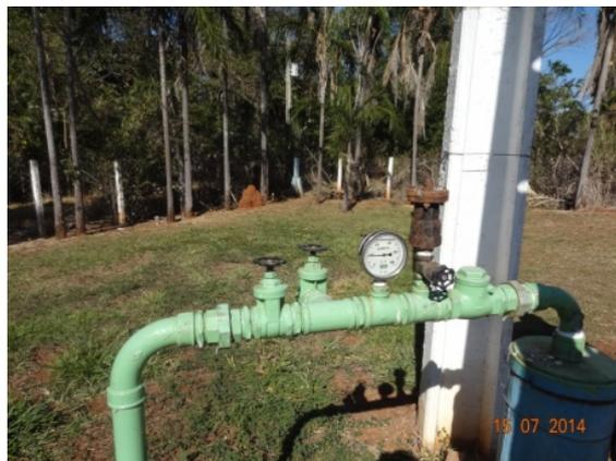
**Foto 3** – Poço perfurado já interligado
