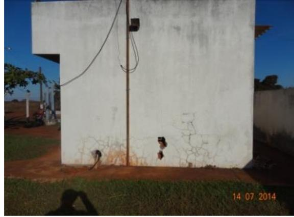
Foto 2 – Parede com rachaduras e buracos
