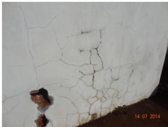
Foto 3 – Detalhes das rachaduras e do buracos
