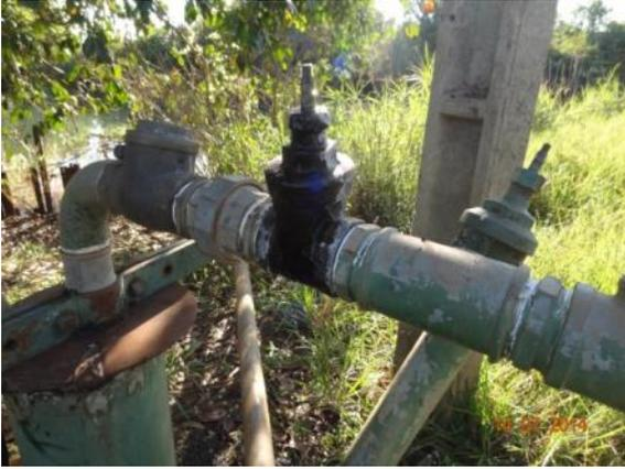
Foto 1 – Vazamento na Válvula
